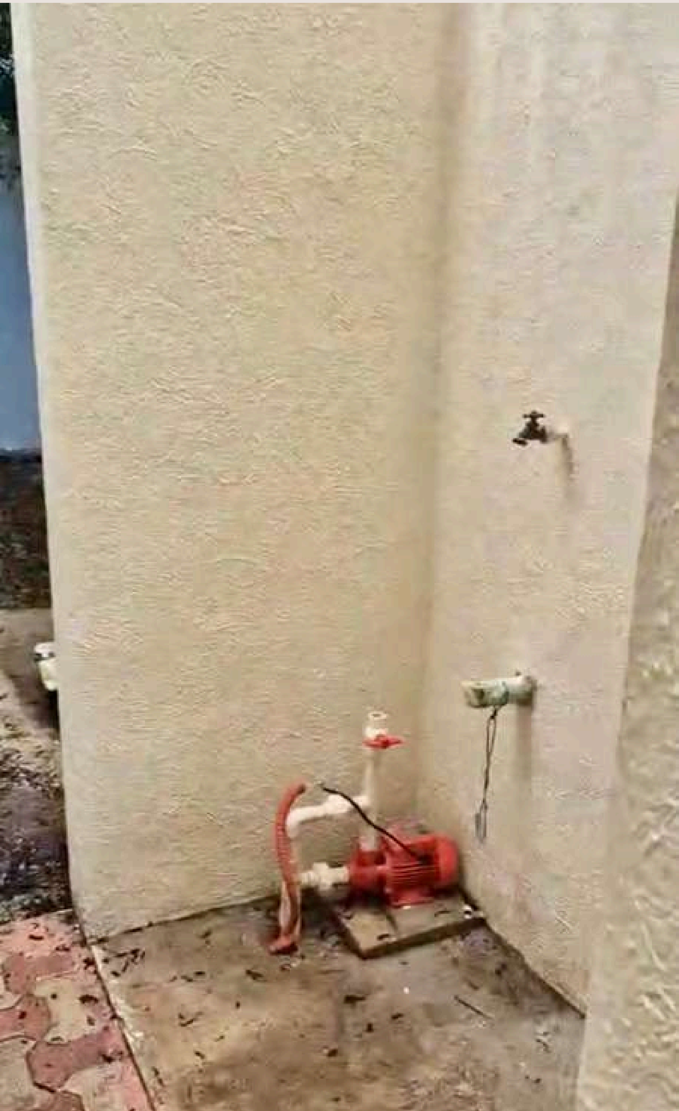
Pasillo lateral con área de lavado
