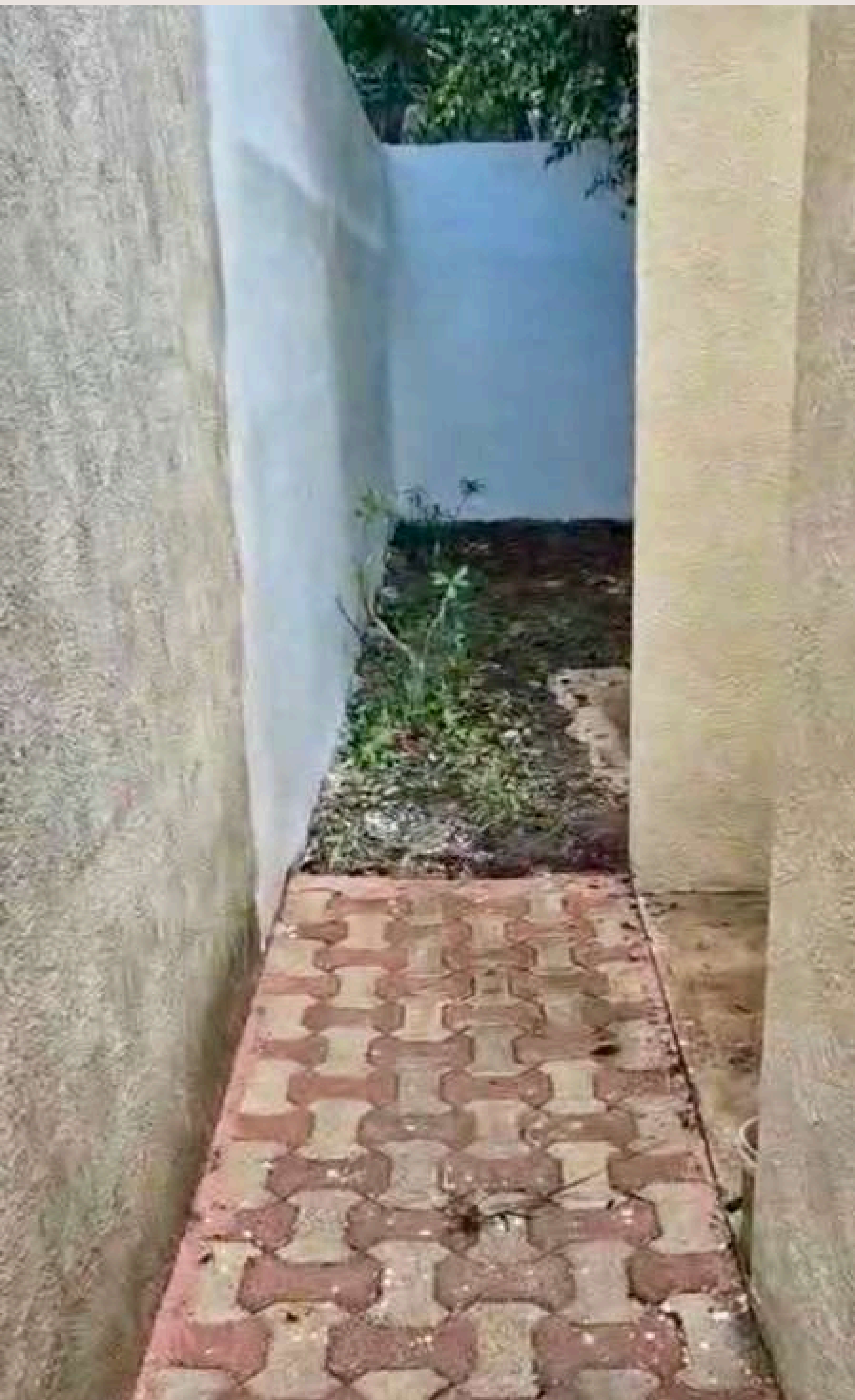
Pasillo lateral con área de lavado
